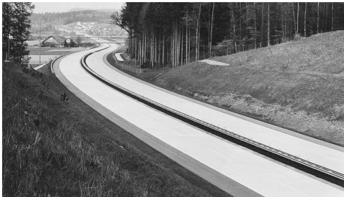
Der Abschnitt der N1 im Aargau wurde durch die Verwendung von Betonplatten zur schweizweit bekannten Holperpiste. Den Entscheid für weissen Belag (Beton) fällte der Regierungsrat gegen die Empfehlungen der Ingenieure des Nationalstrassenbüros. Bild: Archiv Emil Frey AG
