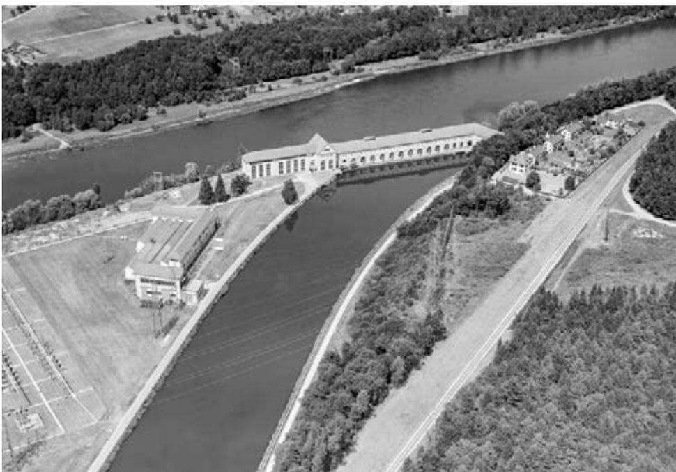
295 Kraftwerk Beznau, 1964. Die frühe Nutzung des Wasserreichtums begründete den Ruf des Energiekantons Aargau. Das Laufkraftwerk Beznau aus dem Jahr 1902 legte den Grundstein für die NOK. Zusammen mit dem Speicherkraftwerk Löntsch bildete es schon früh einen Verbund, der Bandenergie mit Spitzenenergie aus Speicherseen ergänzte.
