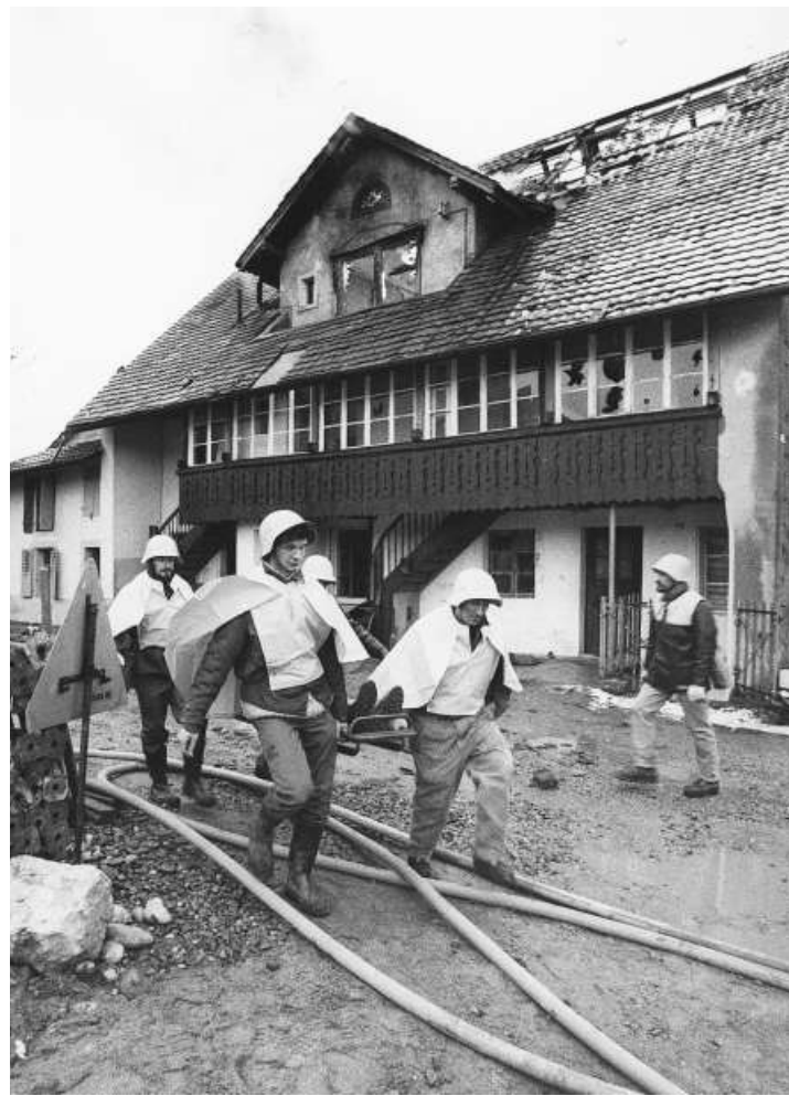
Helme und Überkleider: Eine Zivilschutzübung bei einem Abbruchobjekt in Brugg im Jahr 1987. Foto: Stadtarchiv Brugg
