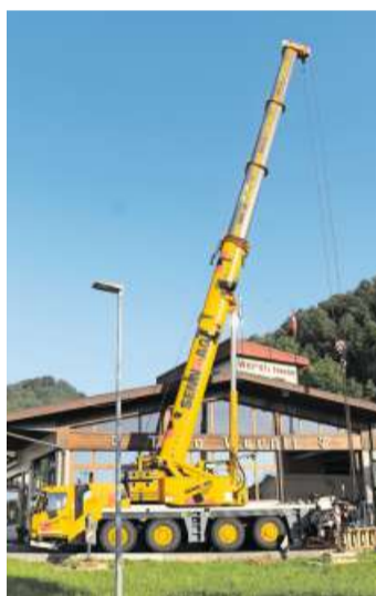
Mit dem Mobilkran werden die Maschinenteile ausgeladen.
