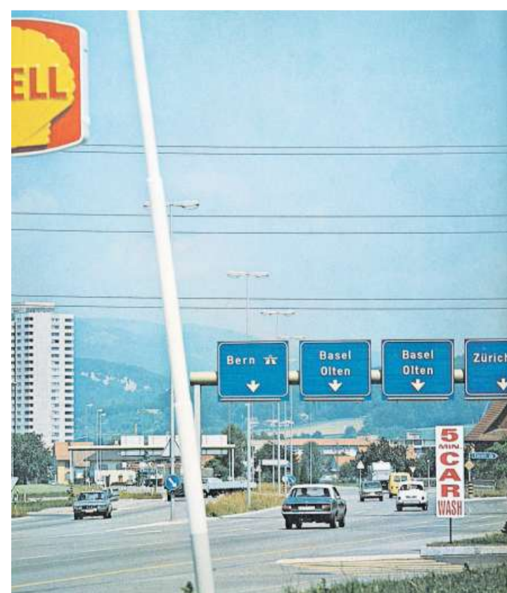
Einfahrt Oftringen, fotografiert 1971.
