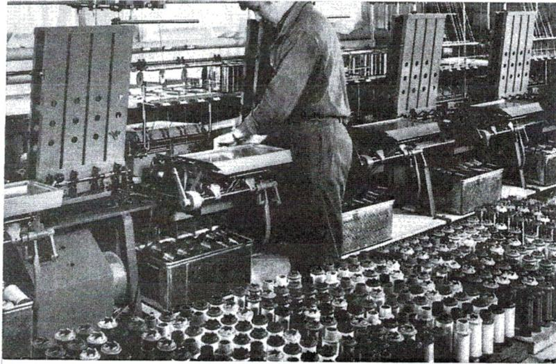
▲ Automatische Spulmaschine
