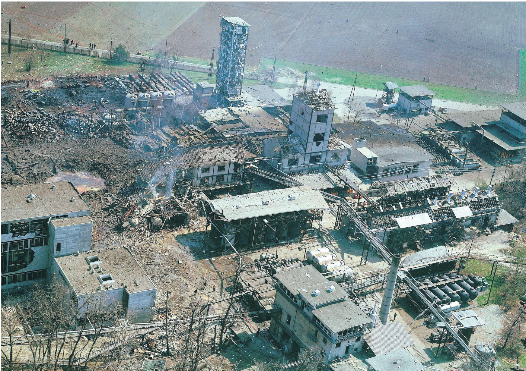
Die Aufnahme ist am 8. April 1969 entstanden: Sie zeigt den Ort der Katastrophe und die völlig verwüstete Sprengstofffabrik in Dottikon.
