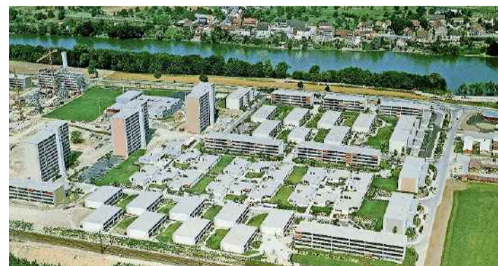
Luftaufnahme der Siedlung Augarten Rheinfelden während der Bauzeit 1974. Bild: ETH-Bildarchiv
